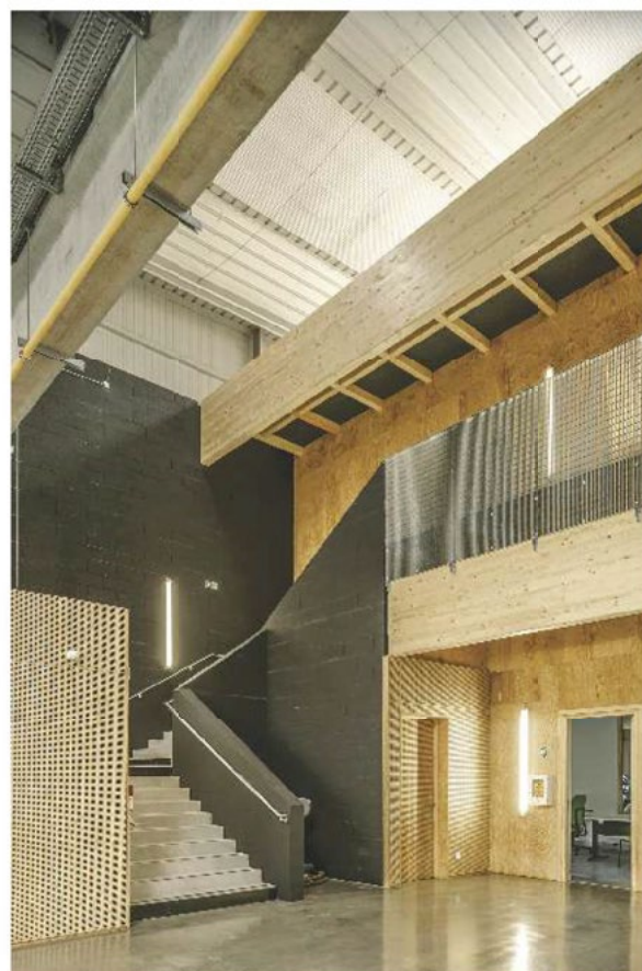
Escalier ouvert en béton menant à l'étage.
